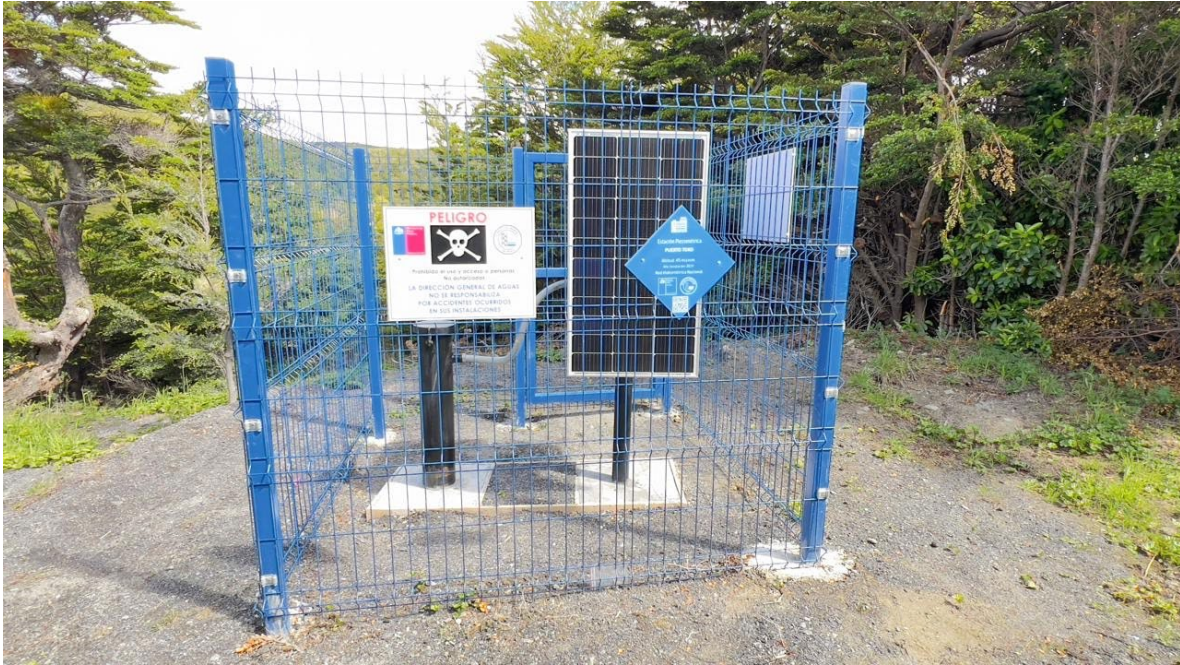
Imagen 9 Estación Piezométrica Puerto Toro
