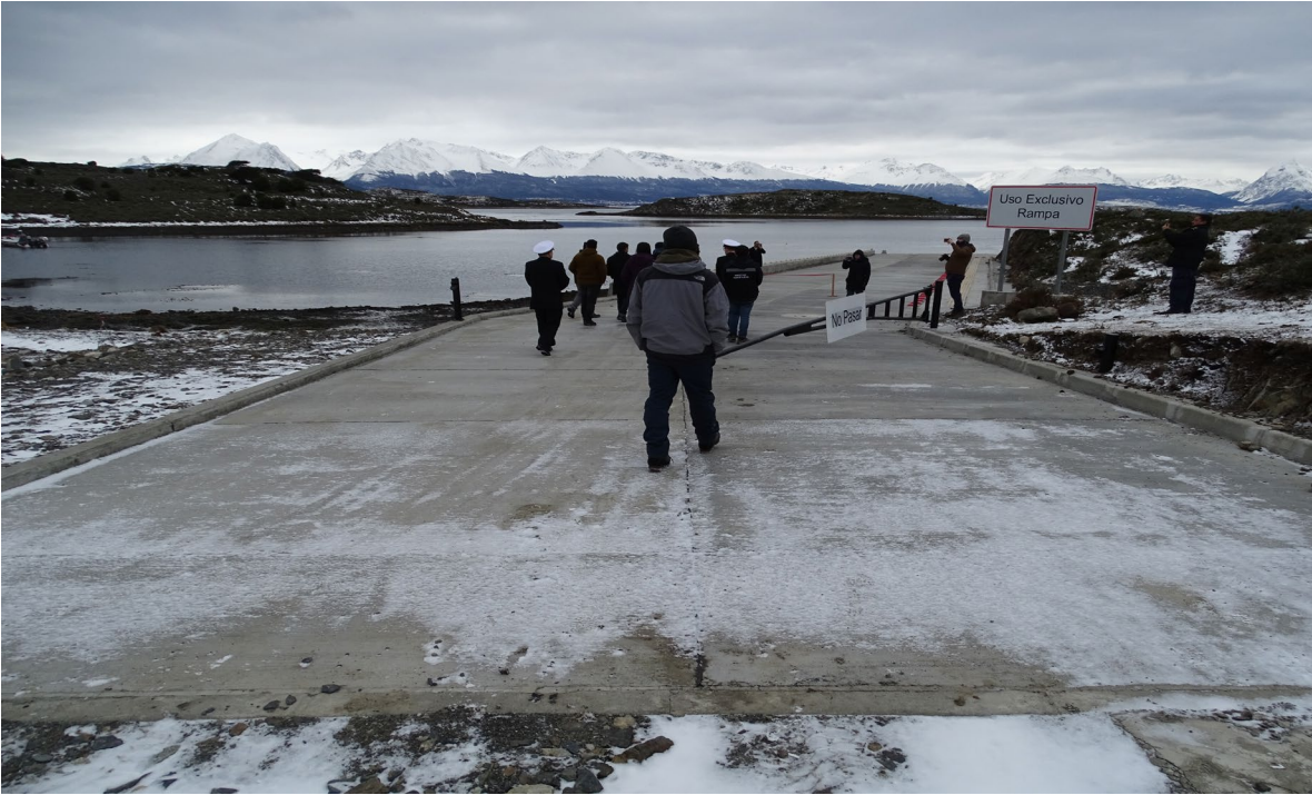
Imagen 5 Construcción Rampa Puerto Navarino
