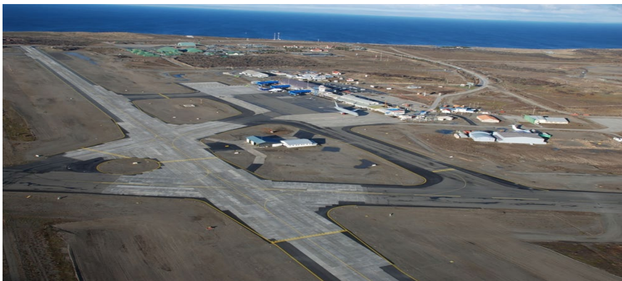
Imagen 7 Mejoramiento Área de Movimiento Aeropuerto presidente Ibáñez R12, Punta Arenas
