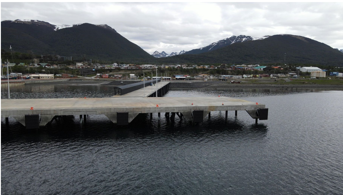
Imagen 6 Construcción Infraestructura Portuaria Multipropósito, Puerto Williams
