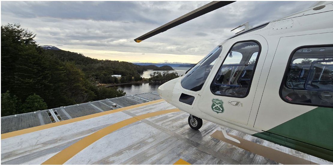
Imagen 8 Construcción Punto de Posada Helicópteros en Puerto Toro
