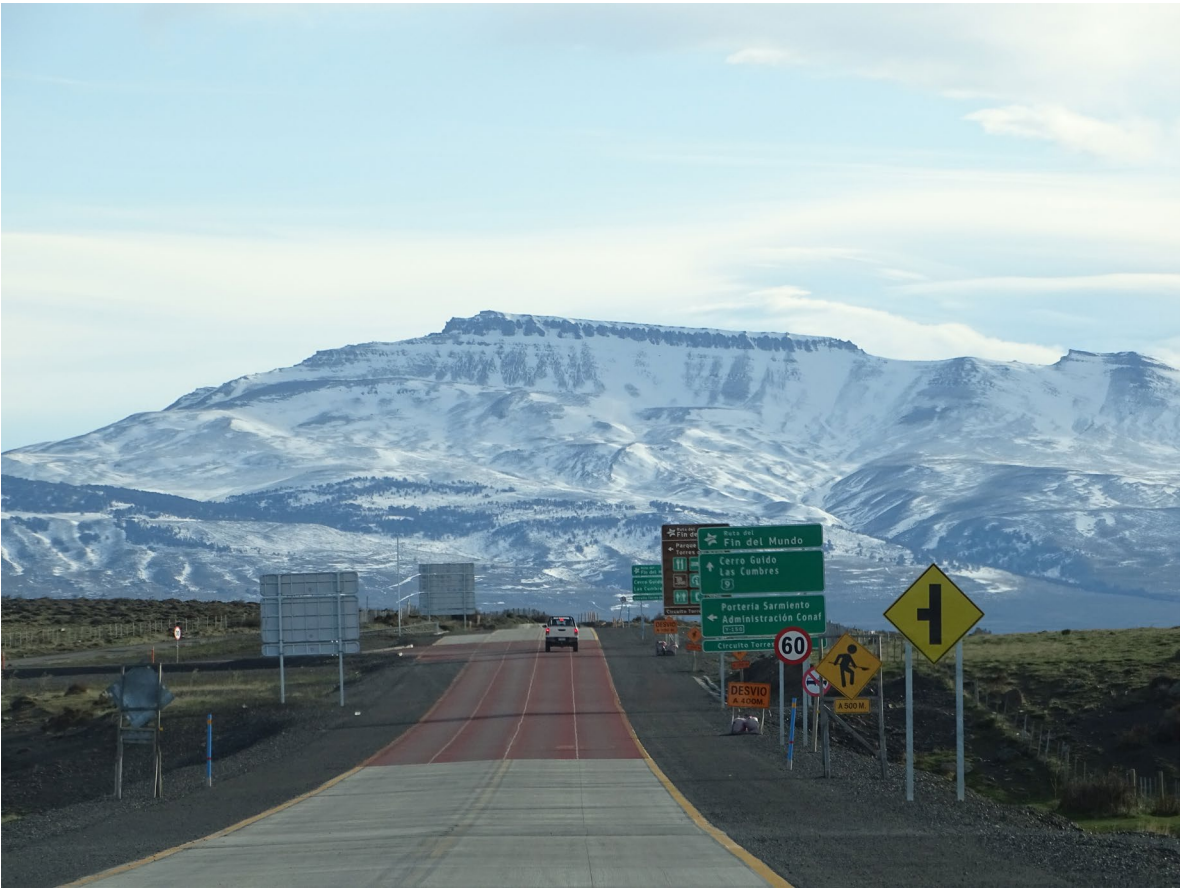
Imagen 4 Mejoramiento Rutas Y-150 e Y-156 Cruce Ruta 9 - Guardería Sarmiento
