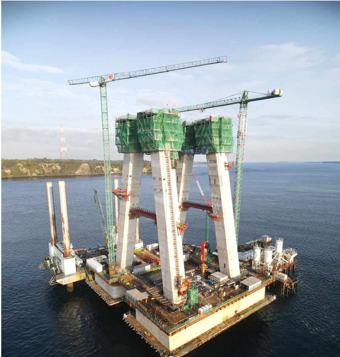
Pila Central Puente sobre el Canal de Chacao
