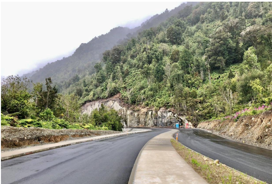
Obra Ruta 7 Sector Hornopirén - Pichanco.
