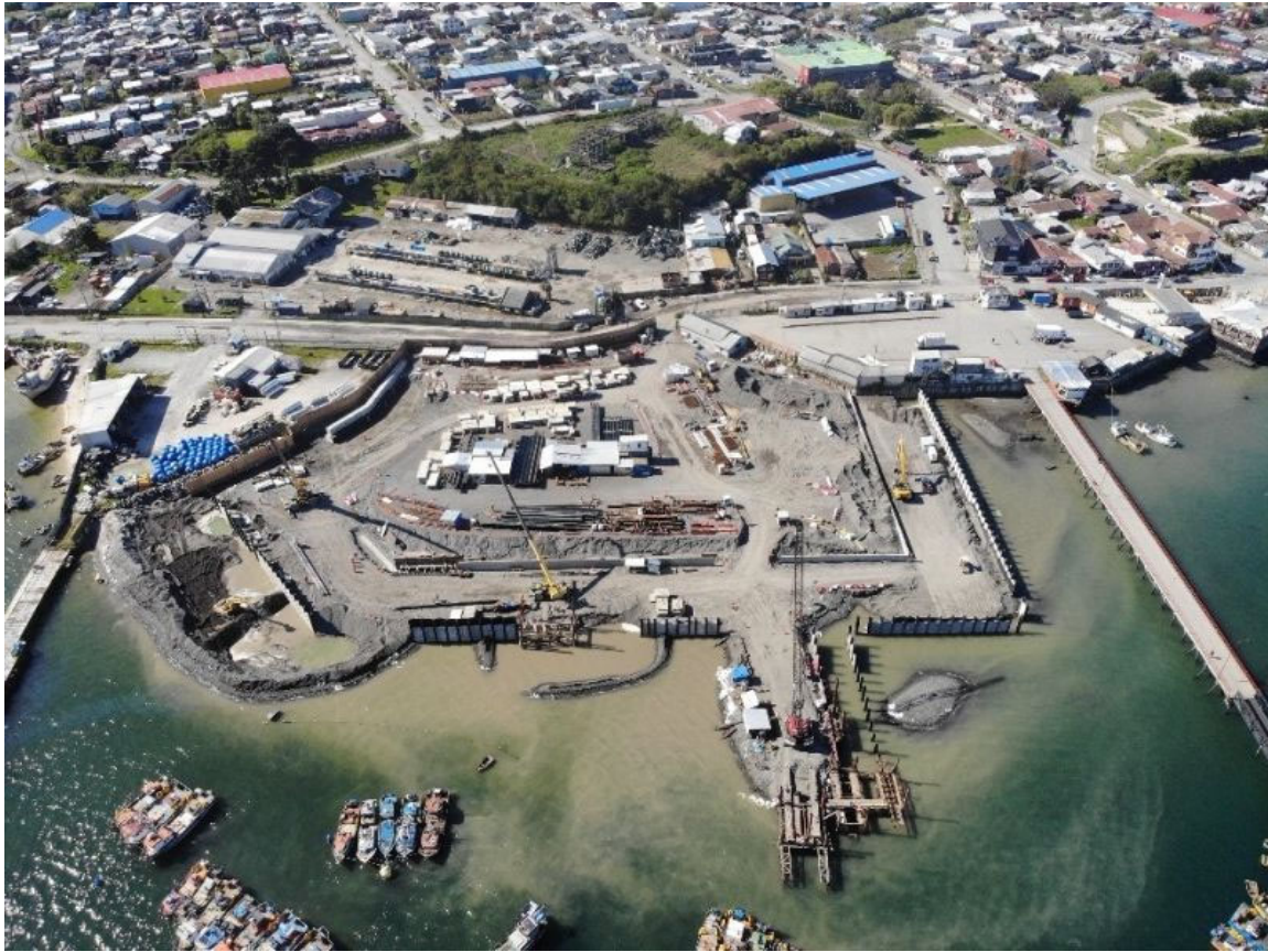
Vista Aérea Obra Mejoramiento Varadero Puerto Pesquero Quellón – Etapa 1.
