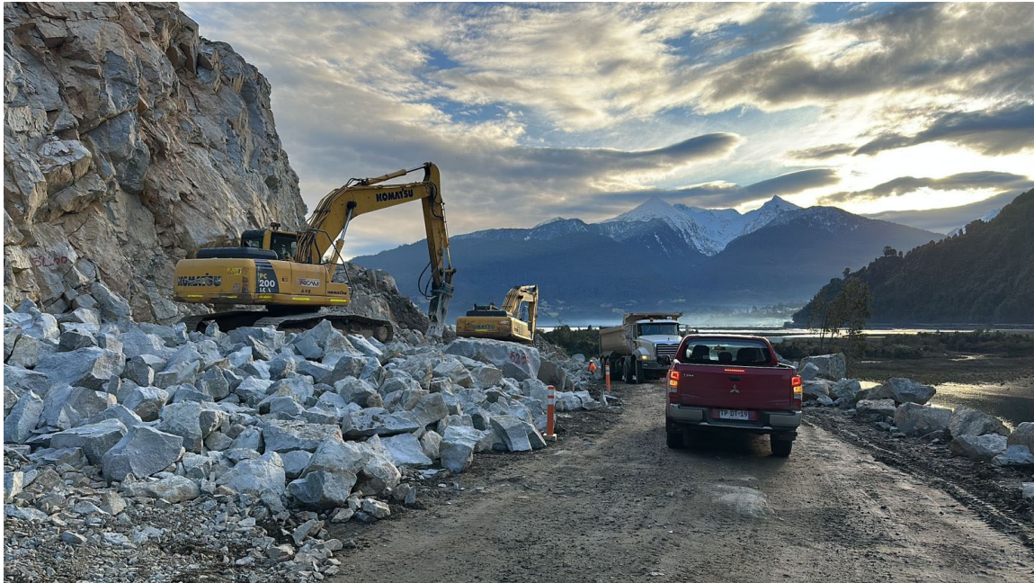
Vista Corte en Roca Ruta V-69 Sector: Pte. Cochamó - Pte. Pucheguín.
