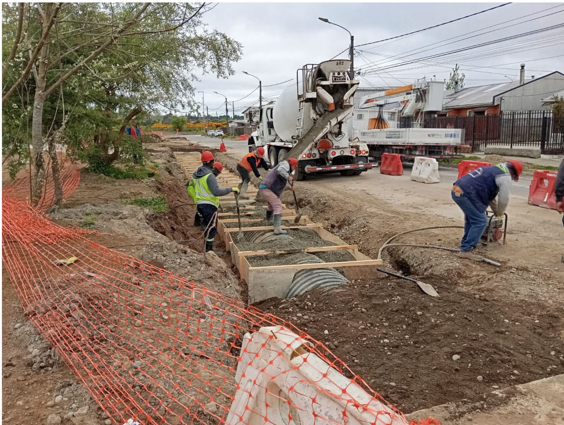
Obra Construcción Colector Red Primaria Zurita de Alerce
