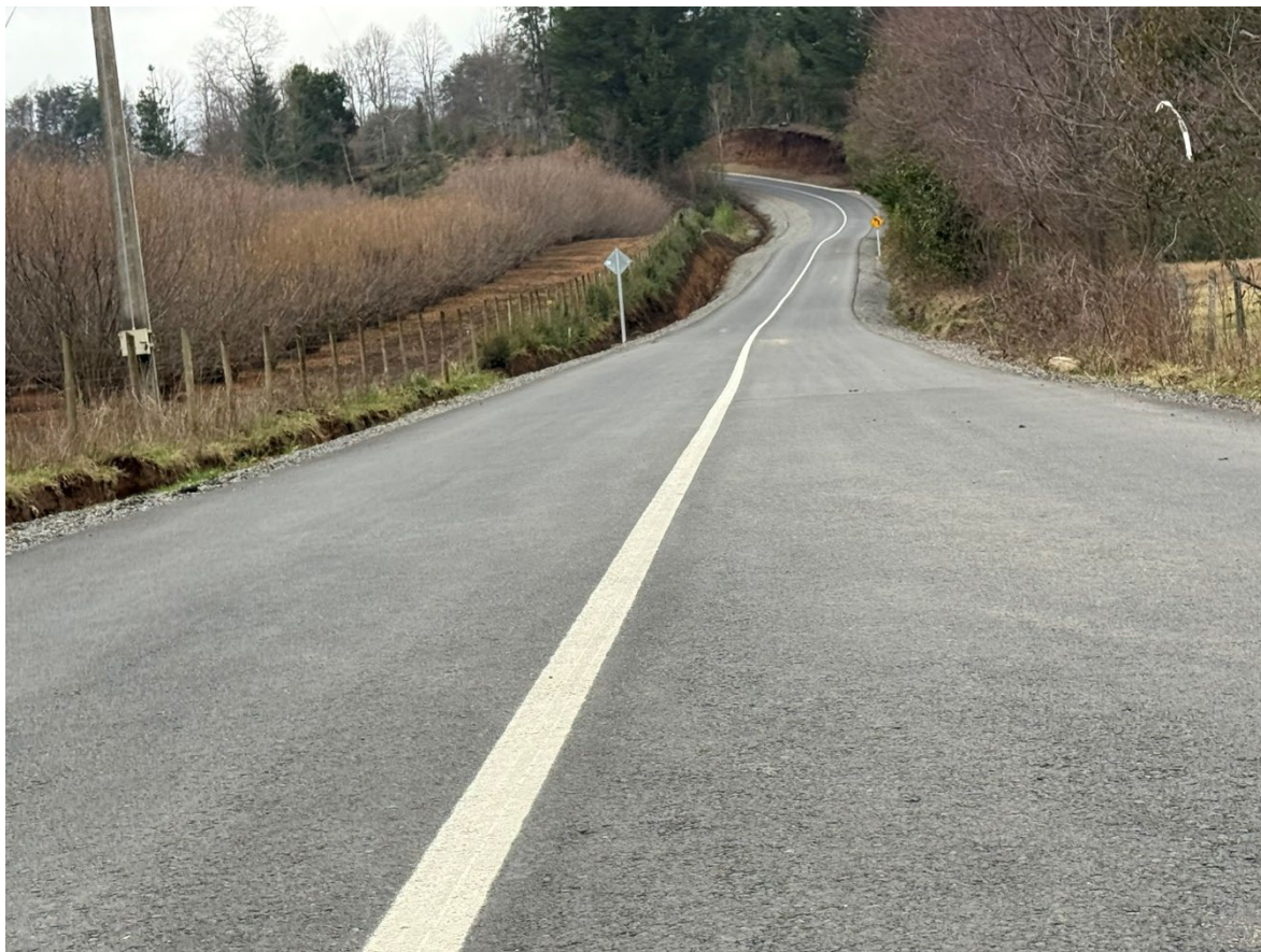
Foto: Conservación Camino Básico, Curaco-Cherquenco, Comuna de Vilcun.
