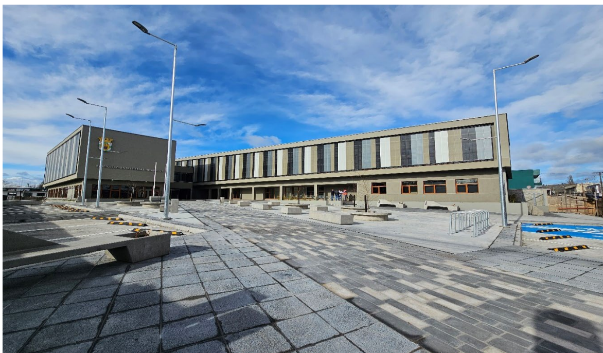
Foto: Edificio Consistorial, Angol.
