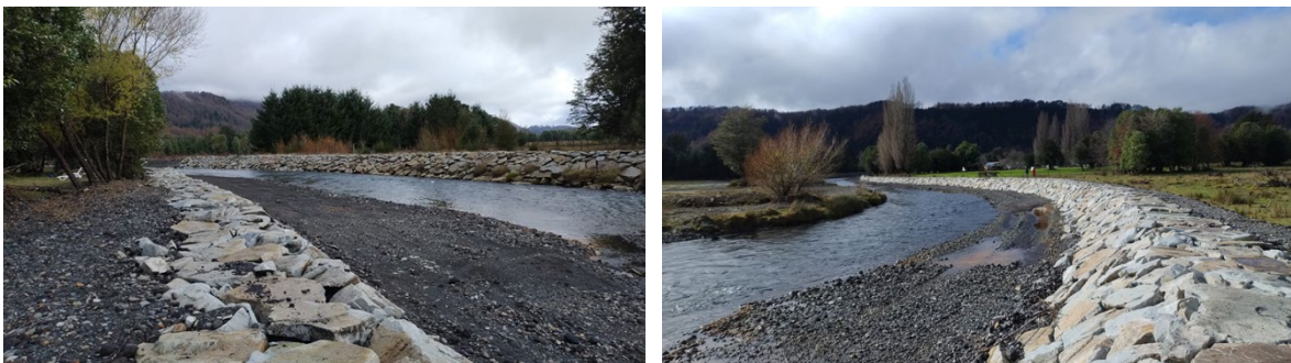
Foto: Conservación de Ribera con enrocado en Río Alpehue, Comuna de Melipeuco.
