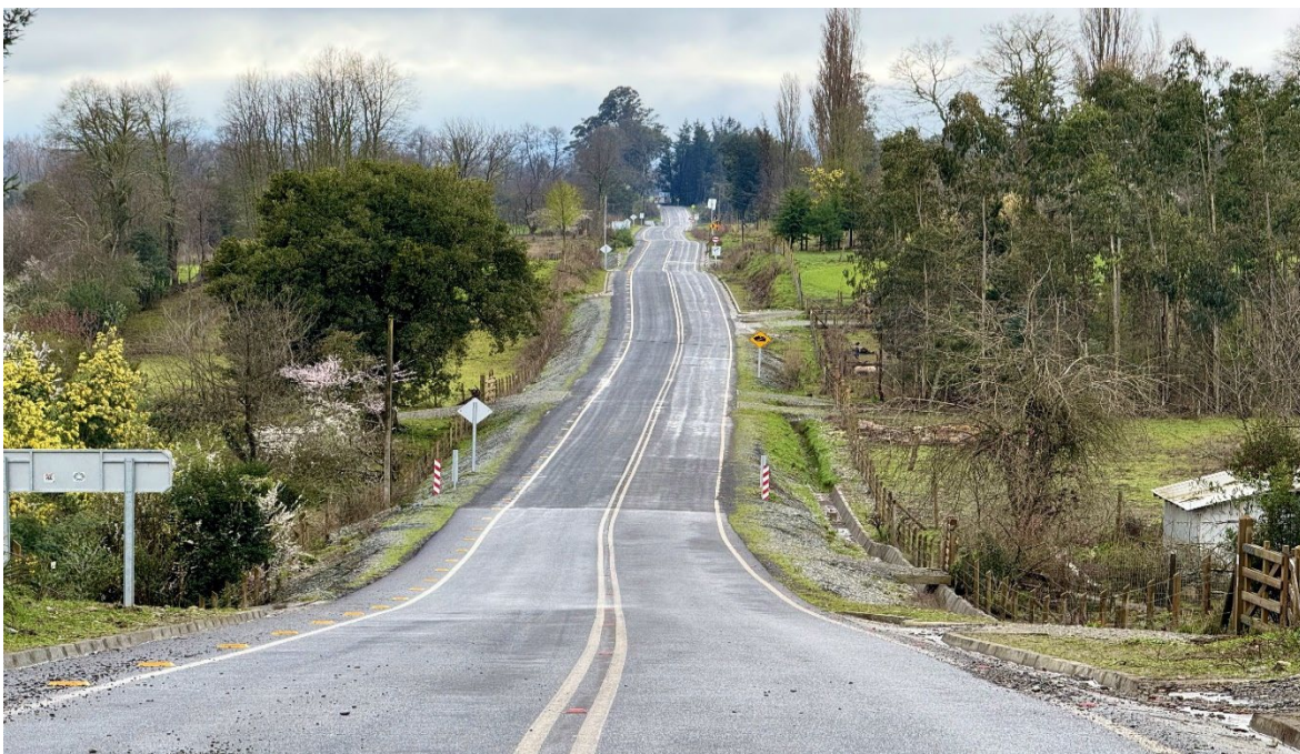
Foto: Mejoramiento camino Básico Intermedio, acceso Quilas Bajas, Comuna de Freire.
