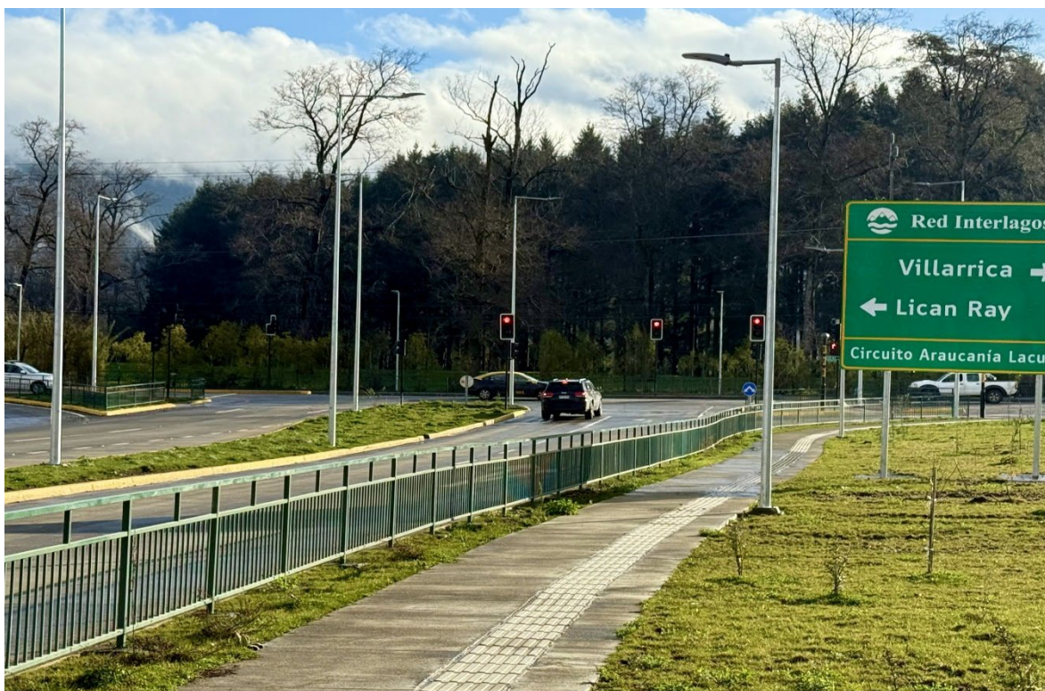
Foto: Ampliación Ruta S-839 Segunda Faja al Volcán, Comuna de Villarrica.
