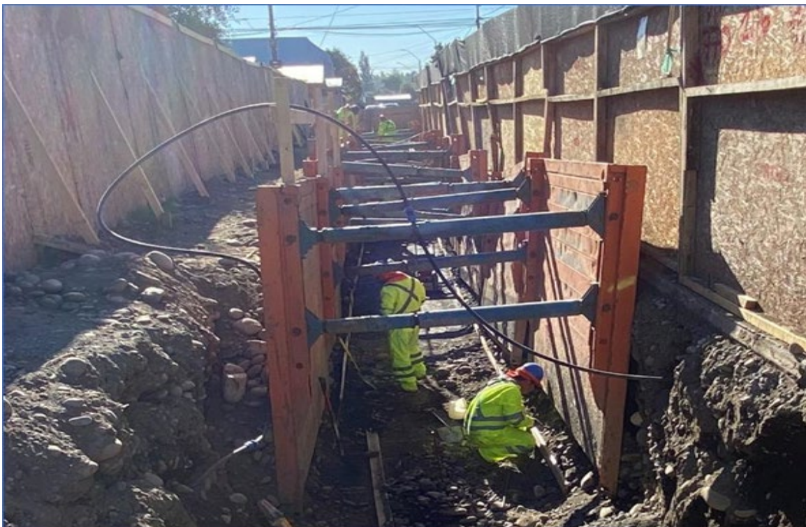
Foto: Construcción Colector Interceptor Aguas Lluvias Santa Rosa, Comuna de Temuco.
