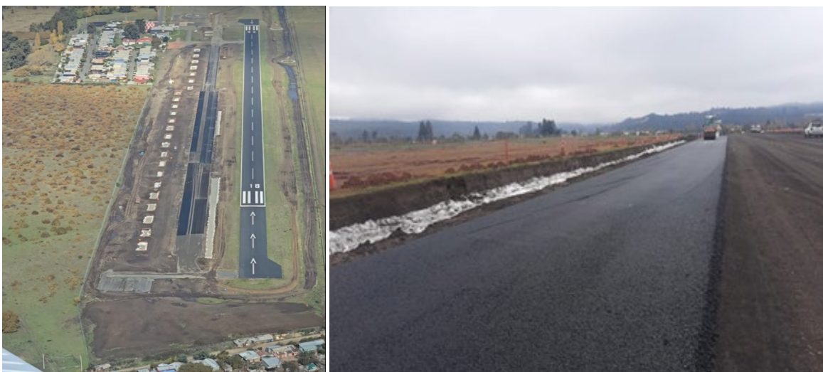
Foto: Pista Aeródromo Los confines de Angol, Etapa 2 y Punto de Posada.
