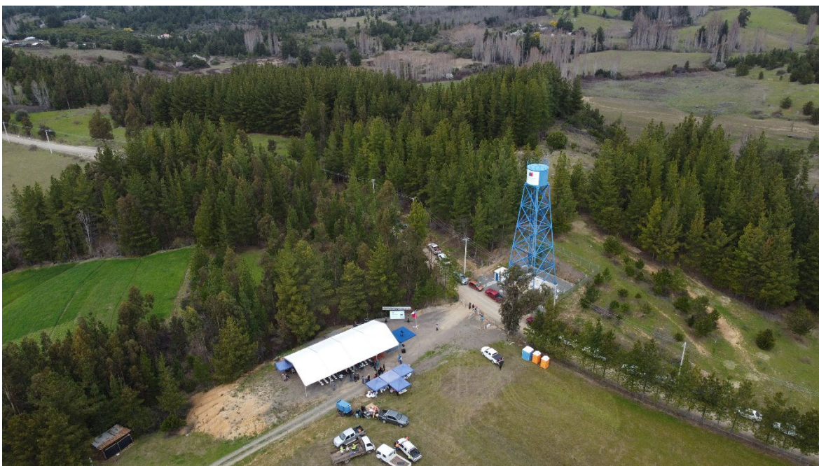
Estanque elevado SSR Turquí, comuna de San Rosendo
