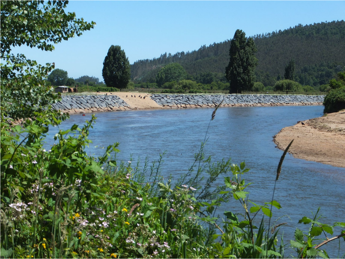
Limpieza y enrocado del cauce del río Lía, comuna de Arauco
