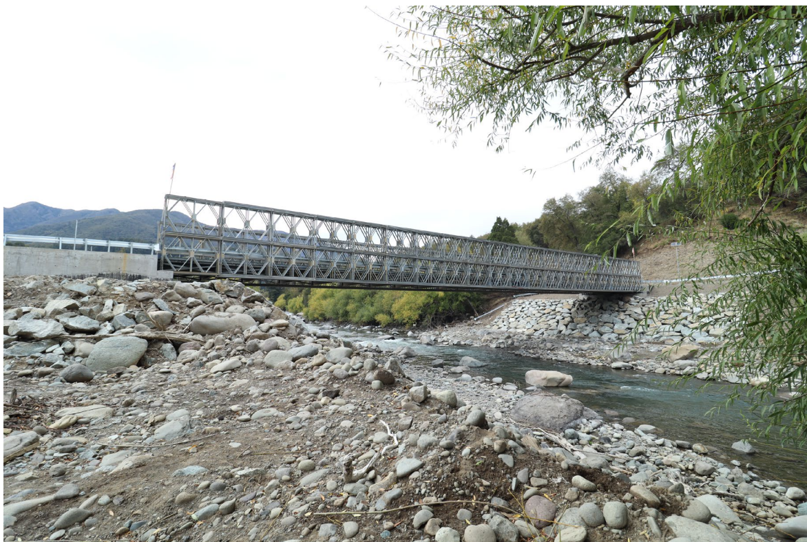
Reposición puente Chichintahue sobre el cauce del río Queuco, Alto Biobío
