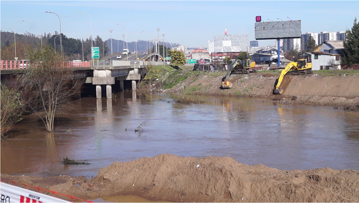
Limpieza y perfilamiento del cauce del río Andalién, comuna de Concepción
