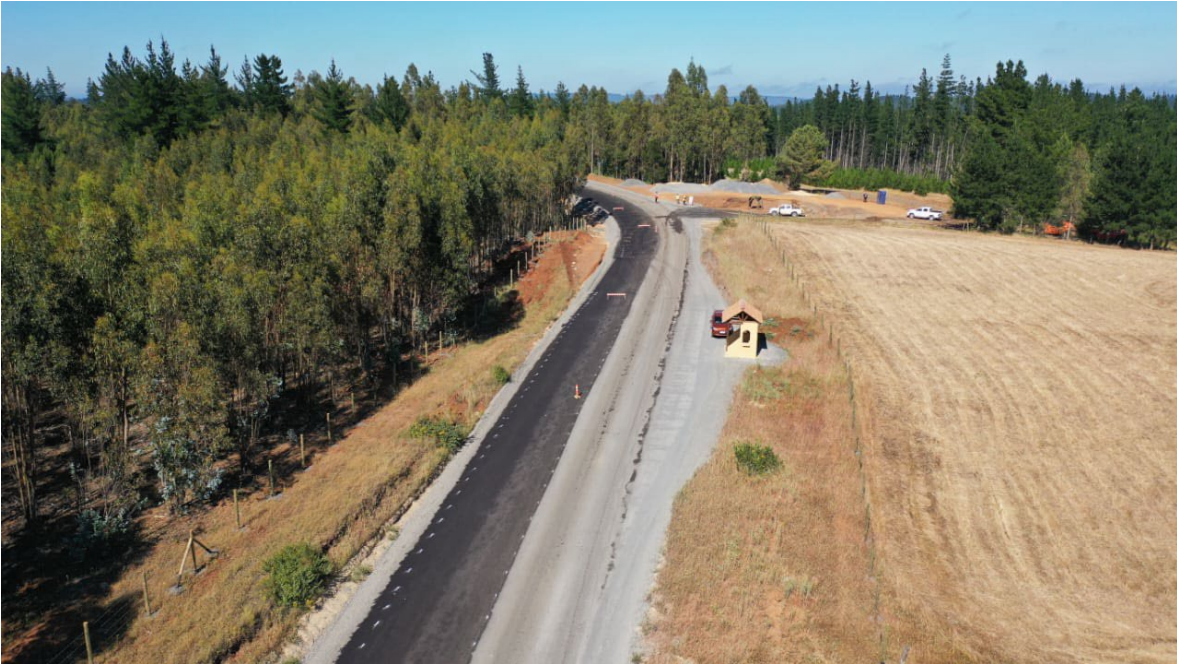
Mejoramiento Ruta Q-60-O, tramo Yumbel-Rere, comuna de Yumbel
