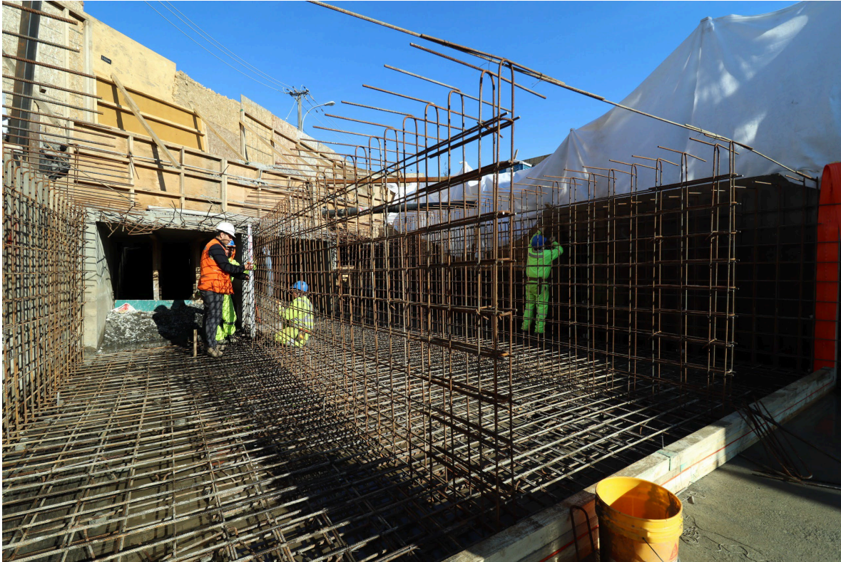
Construcción colector Ramón Carrasco, comuna de Concepción
