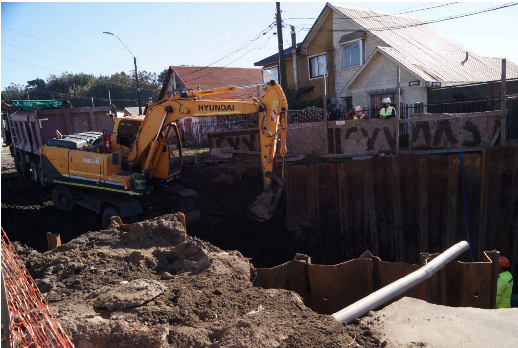
Construcción Colector Sosa, comuna de Talcahuano
