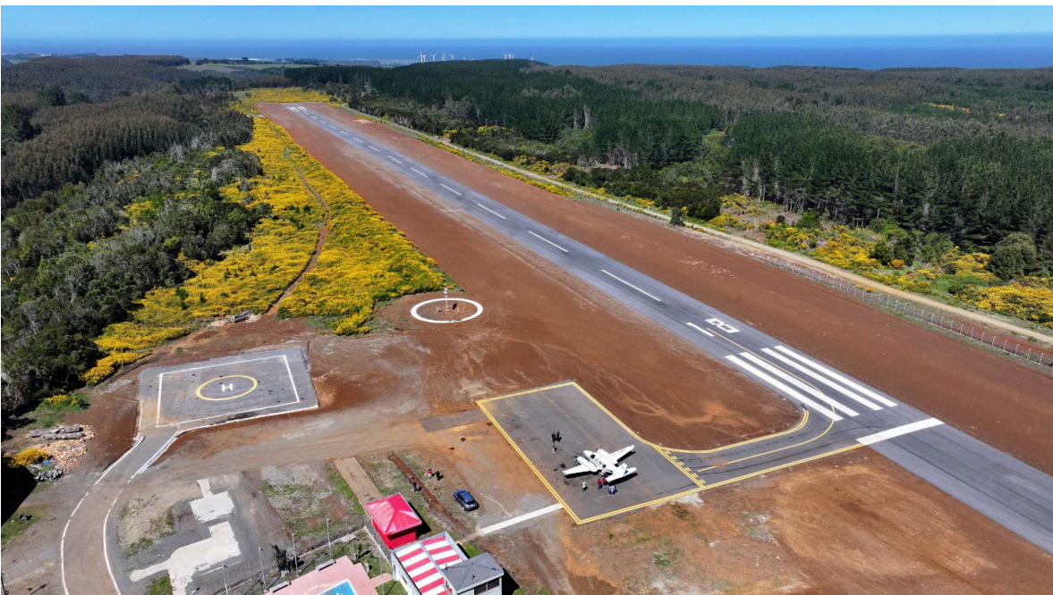
Helipista Aeródromo Los Pehuenches, comuna de Lebu
