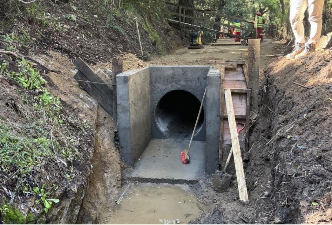
Muro de boca entubamiento Derivado Las Mercedes sector Sergio Vargas
