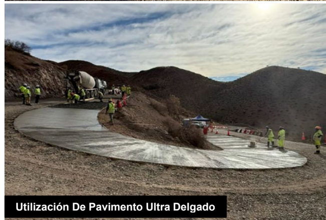
Pavimentación D-445, Vicuña
