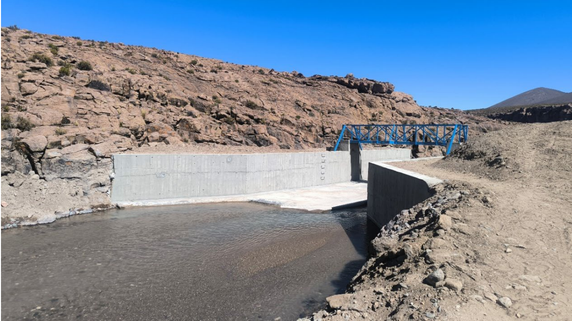
Conservación Estación Fluiométrica Quebrada Camiña en Tarcavire
