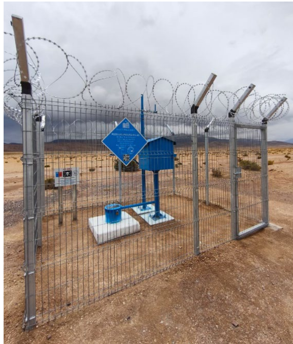
Construcción Pozo Lagunillas
