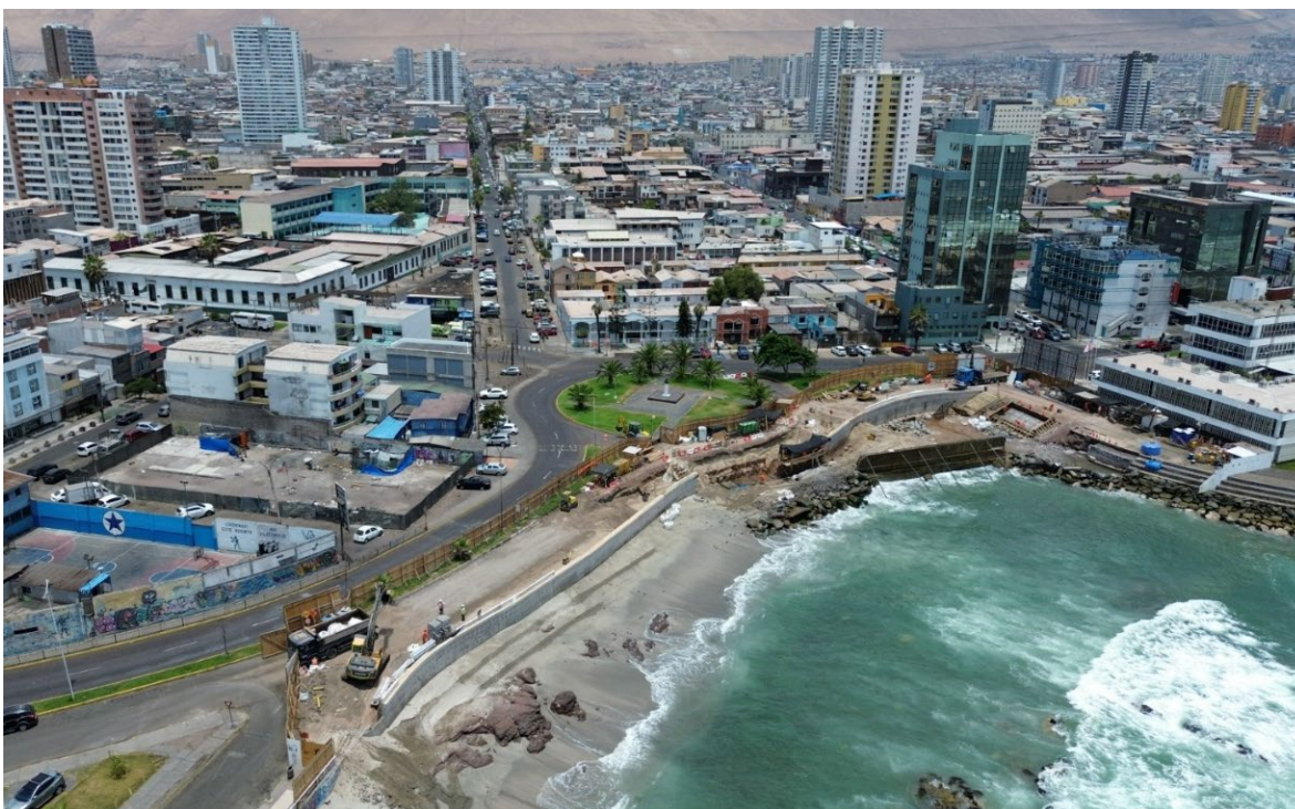
Construcción de Emergencia Muro Protección Costera Bellavista
