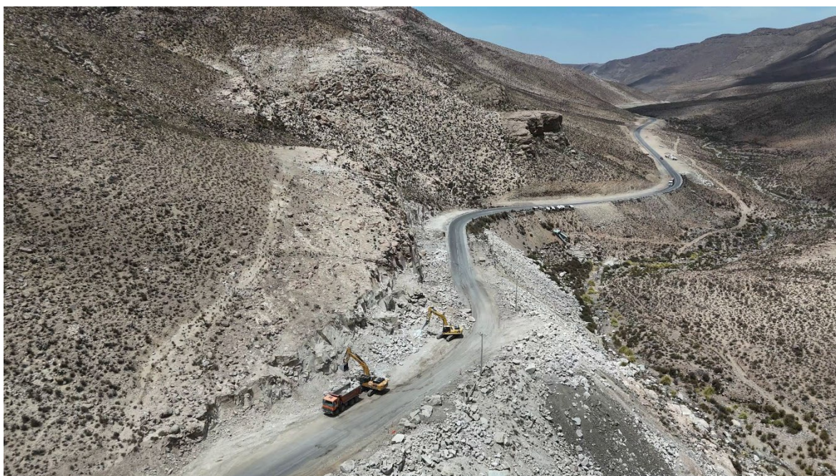
Mejoramiento Ruta 15-Ch Sector Alto Usmagama - Alto Chusmiza, Región de Tarapacá
