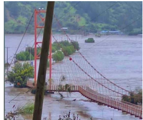
Situación bajo afectación
