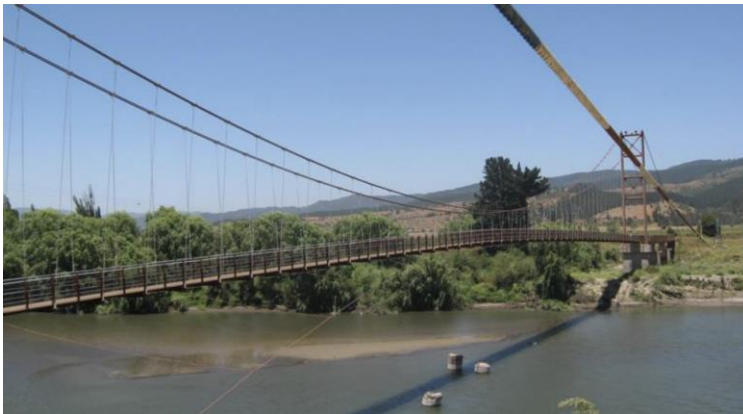
Situación original en pasarela Los Escalones (río Mataquito)
