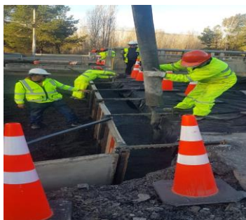
Se realiza relleno con hormigón tras espaldar de estribos norte puentes Batuquito oriente y poniente
