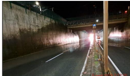
Soterrado próximo a tránsito total.
