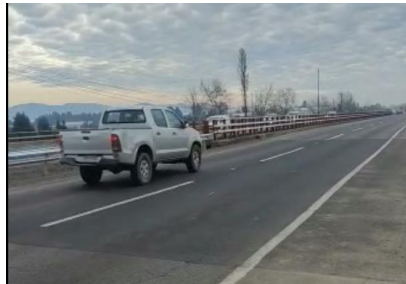
Puente Lircay operativo en agosto
