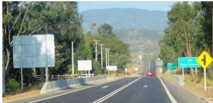
Descripción: Reposición de pavimento de la Ruta E-46 Catapilco- La Laguna etapa II, comuna de Zapallar, en el tramo comprendido entre los Km.0.0 y 12,22. Las principales obras son las siguientes: movimiento de tierras, base asfáltica, sello de grietas, bacheo, carpeta asfáltica, bermas revestidas, mejoramientos puntuales de trazado, obras de drenaje y obras anexas.
