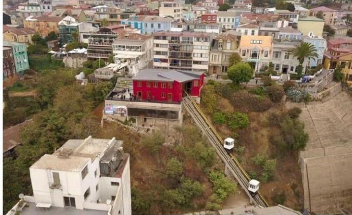
Descripción: El proyecto consistió en la restauración de las estaciones superior e inferior y mejoramiento estructural de las fundaciones, mejoramiento del plano rodadura, de los sistemas electromecánico y de las instalaciones en general.
