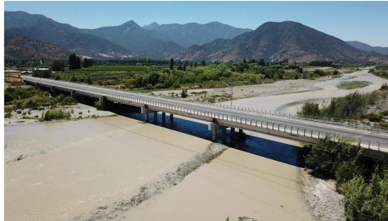
**Descripción:** El proyecto contempló la reconstrucción del puente Coinco en una longitud de 230 metros, reemplazando la estructura anterior la cual había sido deteriorada por causas naturales.
