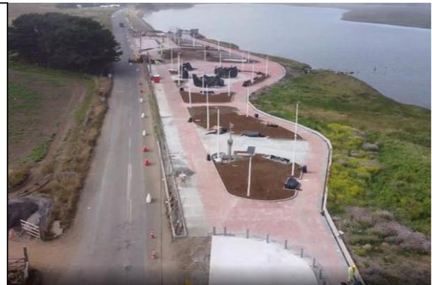
Descripción: Desde el año 1995 se ha ido construyendo por etapas un muro de contención (Losetas de hormigón) en el borde centro sur poniente del pueblo, protegiéndolo contra las marejadas que ingresan en el río Imperial por su desembocadura, junto con esto, la construcción del muro ha generado la recuperación de la rivera materializándose en una explanada, la cual sirve hoy en día como vía de tránsito vehicular y Peatonal.
