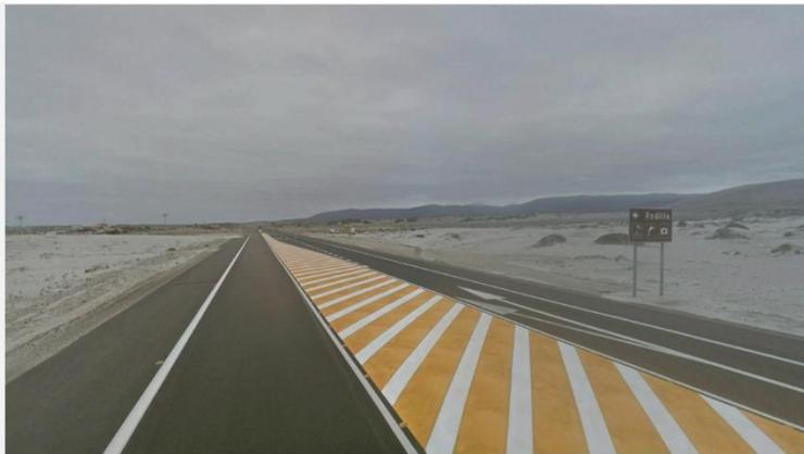
**Descripción:** El proyecto presenta la reposición de 29,25 km de la carpeta asfáltica, entre caldera , km. 888,75 hasta obispio, km 918.0 e incluyó mejorar la plataforma, movimiento de tierra, reposición de la carpeta asfáltica mediante la reconstrucción total de la estructura de pavimento; medidas de seguridad vial, proyecto de iluminación, obras de saneamiento, reemplazo de las obras de arte, obras anexas y medidas ambientales.
