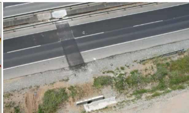
Foto: Modificación de descarga sumidero terminada
