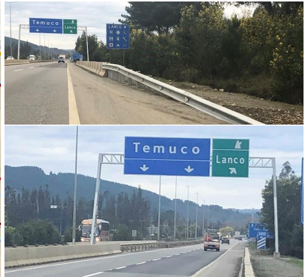
Foto: Señalizaciones instaladas
