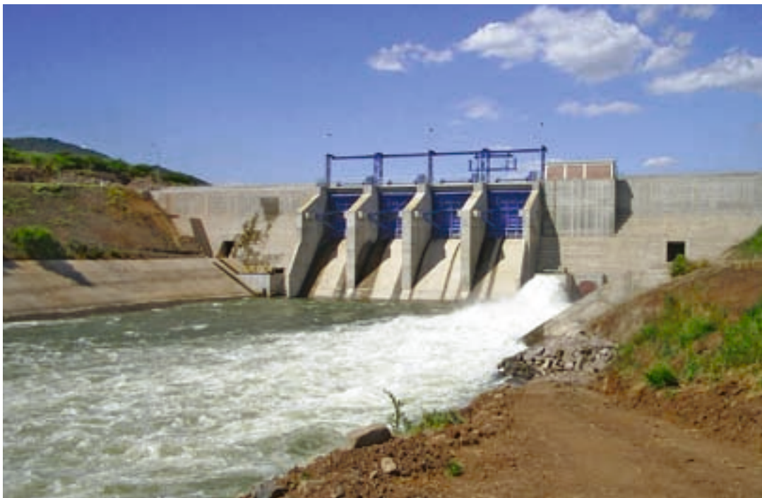
Embalse Convento Viejo, compuertas y válvula Howell-Bunger.
