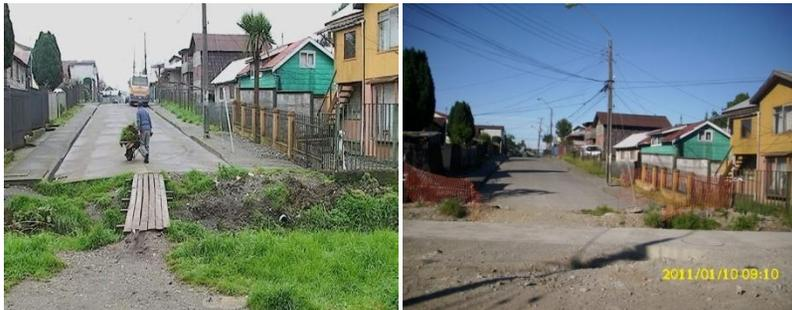
Antes y después de la construcción del colector. (Bajo esta losa está el ducto que es rectangular de sección variable, desde 0,7x0,7 hasta 1,6x2,0).
