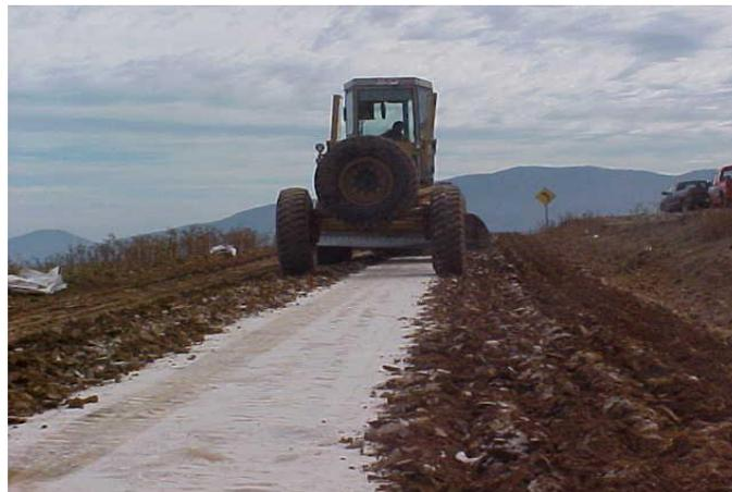
Figura 1.4.1: Recebo de una carpeta granular con adición de cloruro (en la foto: con sal común)
