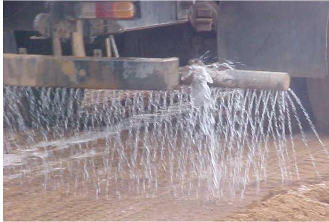
Figura 1.2.1: Riego de salmuera sobre la carpeta de rodadura
