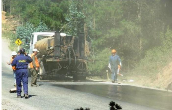
Figura 2.1.1 Riego de asfalto líquido sobre capa asfáltica antigua
