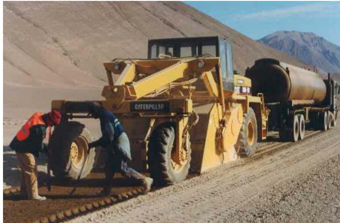
Figura 1.3.2 Reperfilado de un camino con Bischofita, con recicladora
