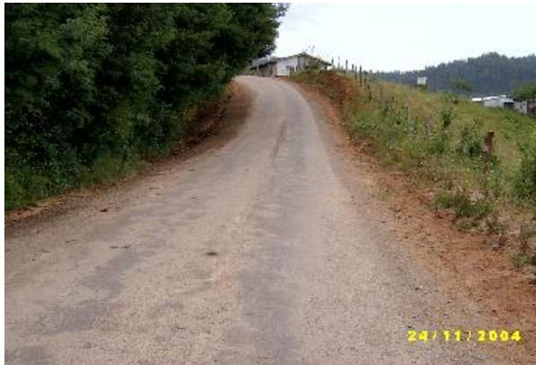
Figura 1.5.1: Riego de cloruro de calcio y resultado final
