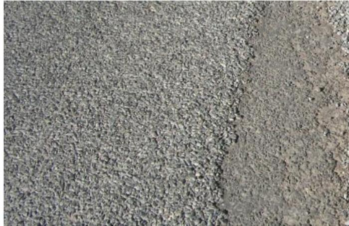
Figura 2.3.1 Capa de sello de agregados sobre la capa de protección antigua
