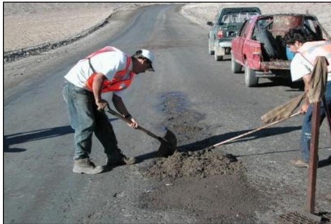
Figura 1.1.1: Bacheo granular con cloruros
