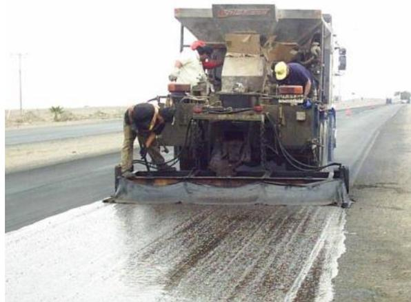
Figura 2.2.1 Aplicación de lechada asfáltica
