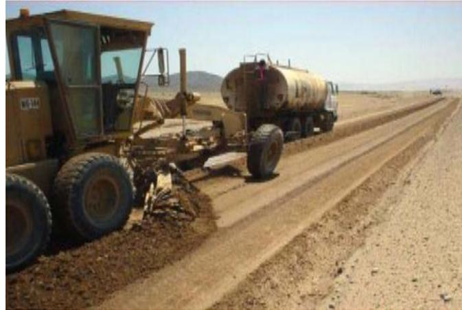
Figura 1.3.1 Reperfilado de un camino con Bischofita, con motoniveladora
