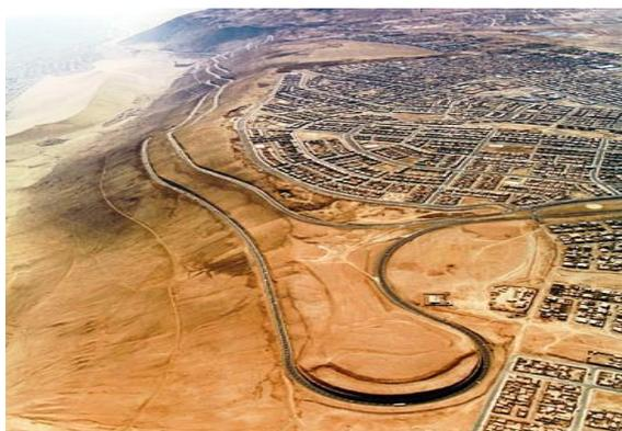
A partir del Km. 3,6 la calzada de subida se separa de la existente hasta empalmar en Alto Hospicio. El resultado es un nuevo eje con dos pistas de subida de menor gradiente, a objeto de facilitar el transporte de carga y disminuir la accidentabilidad en la vía, además de áreas de miradores para la ciudad.
