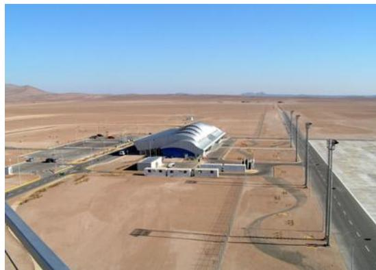
Edificio terminal de pasajeros de 3.000 m<sup>2</sup>; Pista de aterrizaje de 2.200 metros de largo; Rodajes y plataforma de estacionamiento para 4 aviones tipo Airbus-320; Equipamiento Aeroportuario; Torre de Control, edificio DGAC y Cuartel SEI; Planta de tratamiento de aguas servidas; Vialidad de acceso al aeropuerto; Estacionamientos para automóviles; Zonas de circulación peatonal, tratamiento paisajístico, cierros de seguridad y otras obras.
