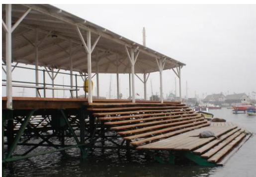
La estructura del Muelle Prat data de los años posteriores a la Guerra del Pacífico y tiene su apogeo en los años de esplendor de la riqueza del salitre. Este proyecto –ya finalizado- contempló la reposición de la madera faltante y recuperación de la existente; mejoramiento del pilotaje, vigas longuerinas y vigas travesaño, además de la estructura de acero soportante.
