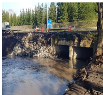
Vía expresa, restituida con rellenos de hormigón y material pétreo, que protege la estructura.
