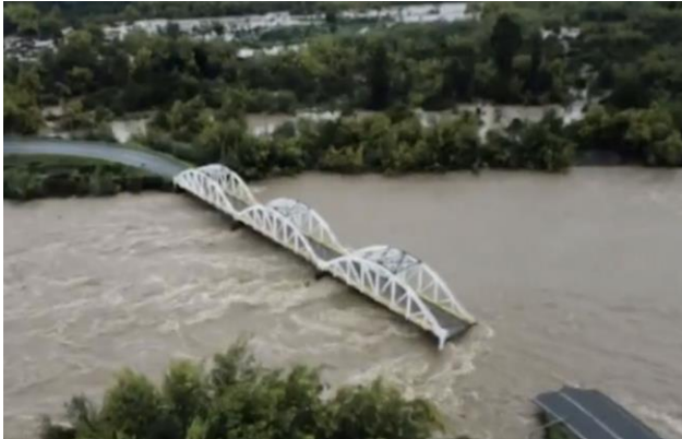
Situación bajo afectación en puente Tres Arcos
