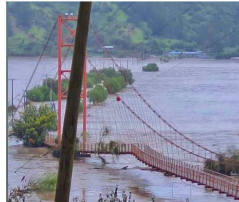
Situación bajo afectación
