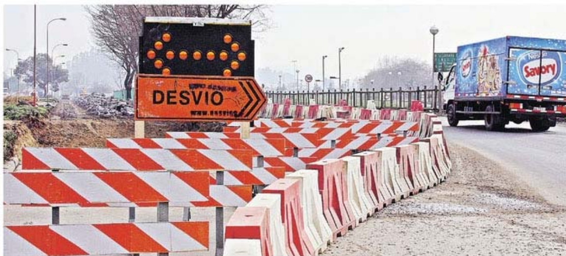
Imagen 3: Desvíos de Tránsito en tránsito desde Ruta 148 hacia Intersección Penco.
