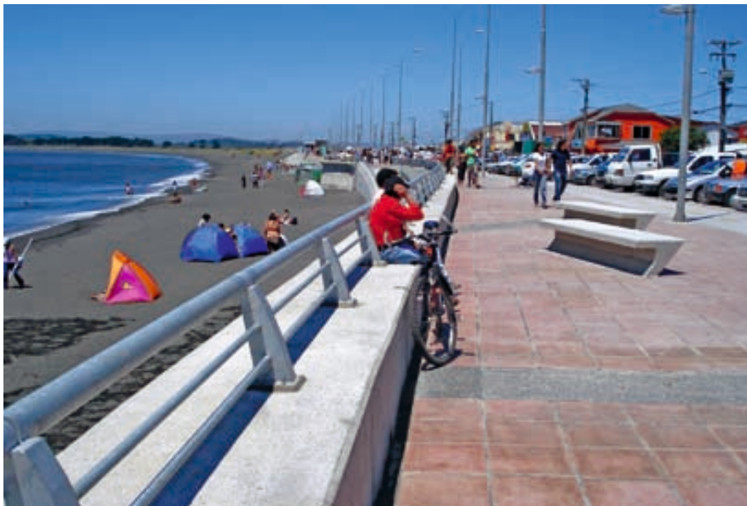
Construcción muro costanera Lenga, comuna de Hualpén.
