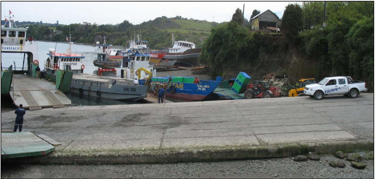
Fotografía 12: Rampa Dalcahue: "Carga y Descarga de Transbordadores Particulares"
