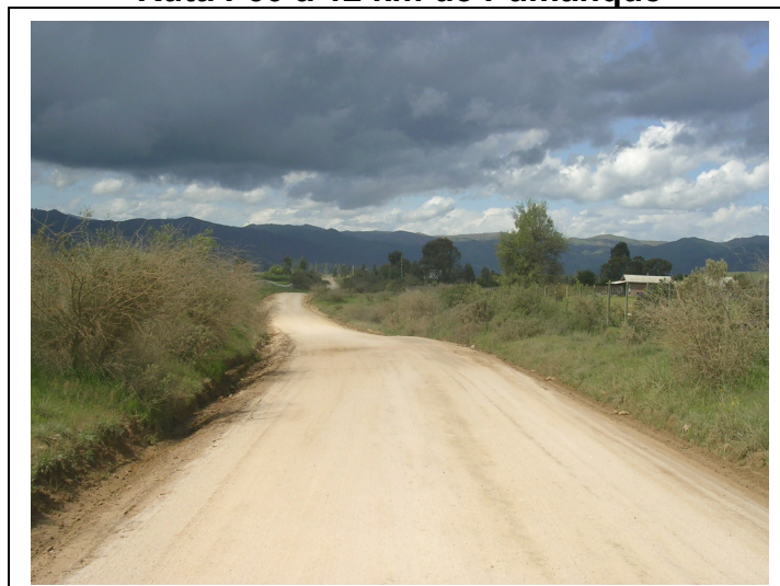
Figura N° -31 Ruta I-60 a 12 km de Pumanque
