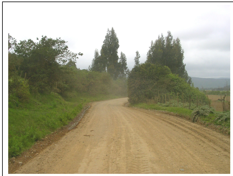
Figura N° -37 Ruta M-24-K a 3 km de Bifurcación Hacia la Trinchera
