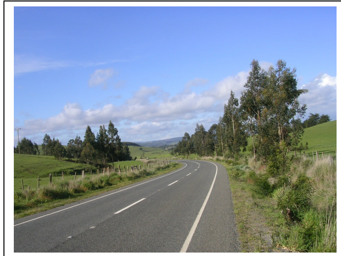
Figura N° -35 Ruta I-72 a 4 km de I-532
