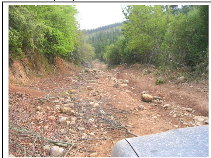
Figura N° -29 Ruta L-45, a 8,9 km del Final del Pavimento
