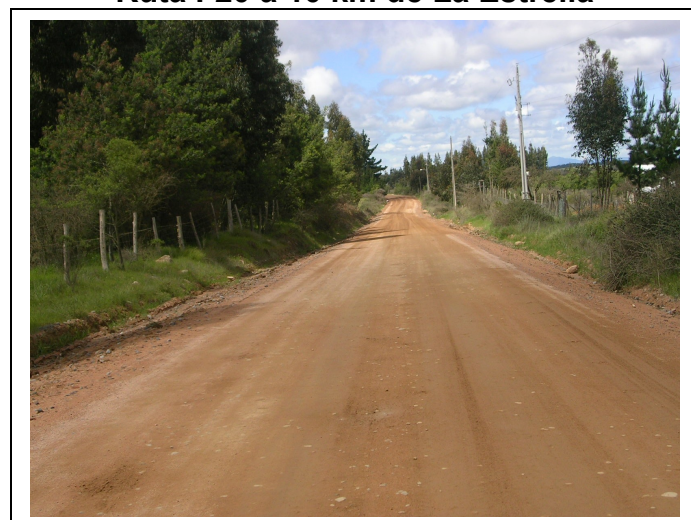
Figura N° -36 Ruta I-20 a 10 km de La Estrella
