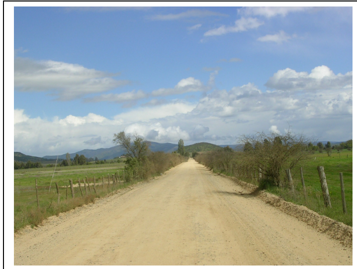
Figura N° -32 Ruta I-70-J a 12 km de I-72
