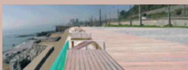
TRAMO DE PASEO SOBRE ANTIGUOS MIRADORES Y ROQUERÍOS.
