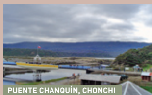
PUENTE CHANQUÍN, CHONCHI
