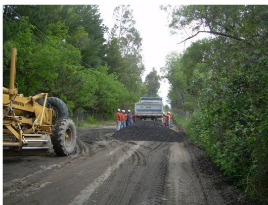
Figura N°2.9 Recebo de Calzada Granular
