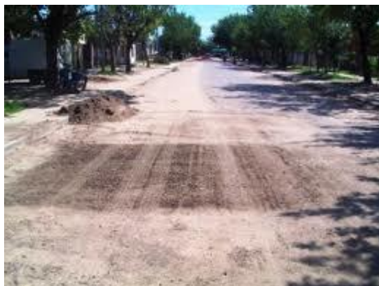
Figura N°2.8 Bacheo de Calzada Granular
