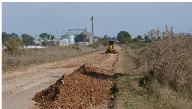
Figura N°2.10 Reparación de la Calzada con Material Integral
