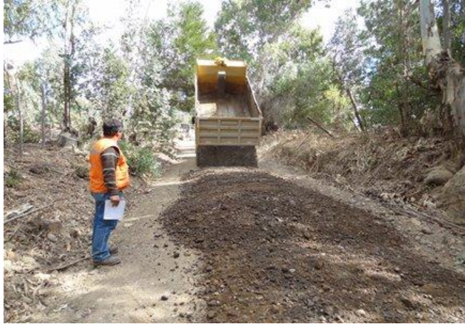
Reparación de calzada con material integral
