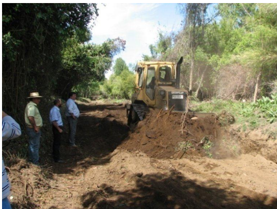
Reparación de áreas inestables
