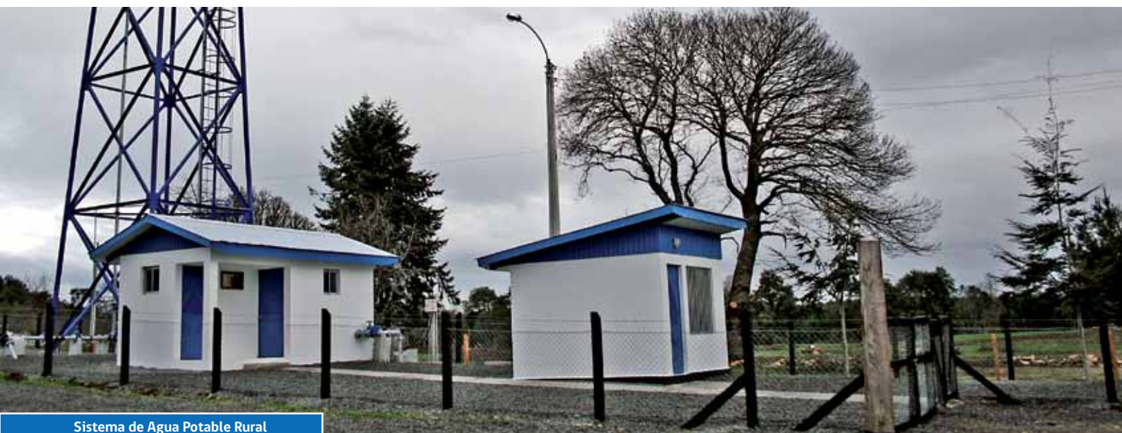
Sistema de Agua Potable Rural
