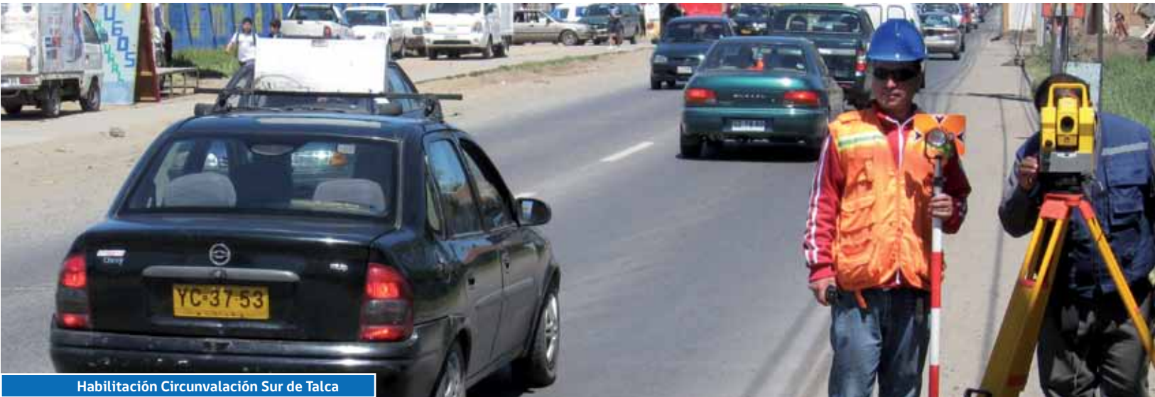
Habilitación Circunvalación Sur de Talca
