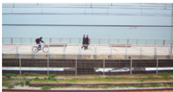
Costanera y Ciclovía en la zona frente a bodegas SAAM y Merval, y sobre desechos y escombros en Playa El Rostro.
